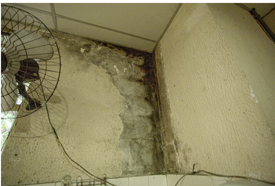
Infiltrações severas na base improvisada e compartilhada pelo Grupamento de Ronda Escolar de toda a cidade e pelo grupamento Especial de Trânsito de Campo Grande, localizada no interior do Centro Esportivo Miécimo da Silva
